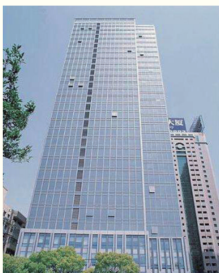
上海京二法人入居ビル
